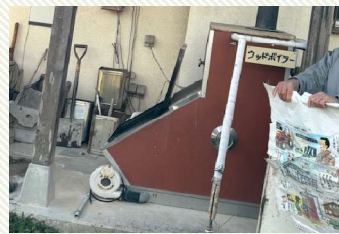
住居部分に使用しているウッドボイラー。木材チップや廃材を利用して温水や暖房に利用できます。
